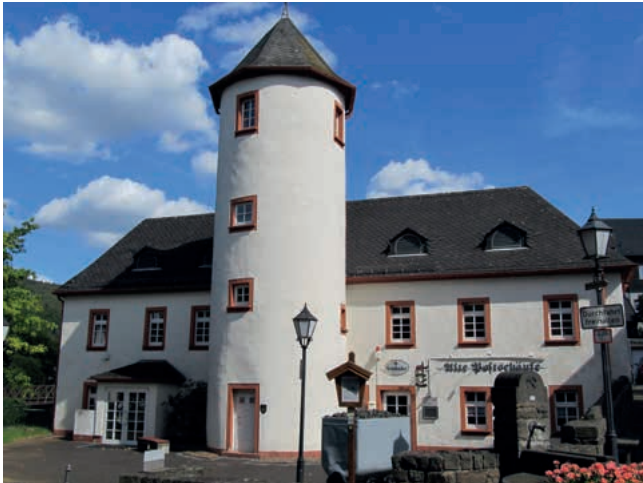
Das Bürgerhaus „Alte Poststation“
