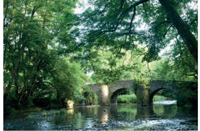
Brücke bei der Klosteranlage Marienstatt
