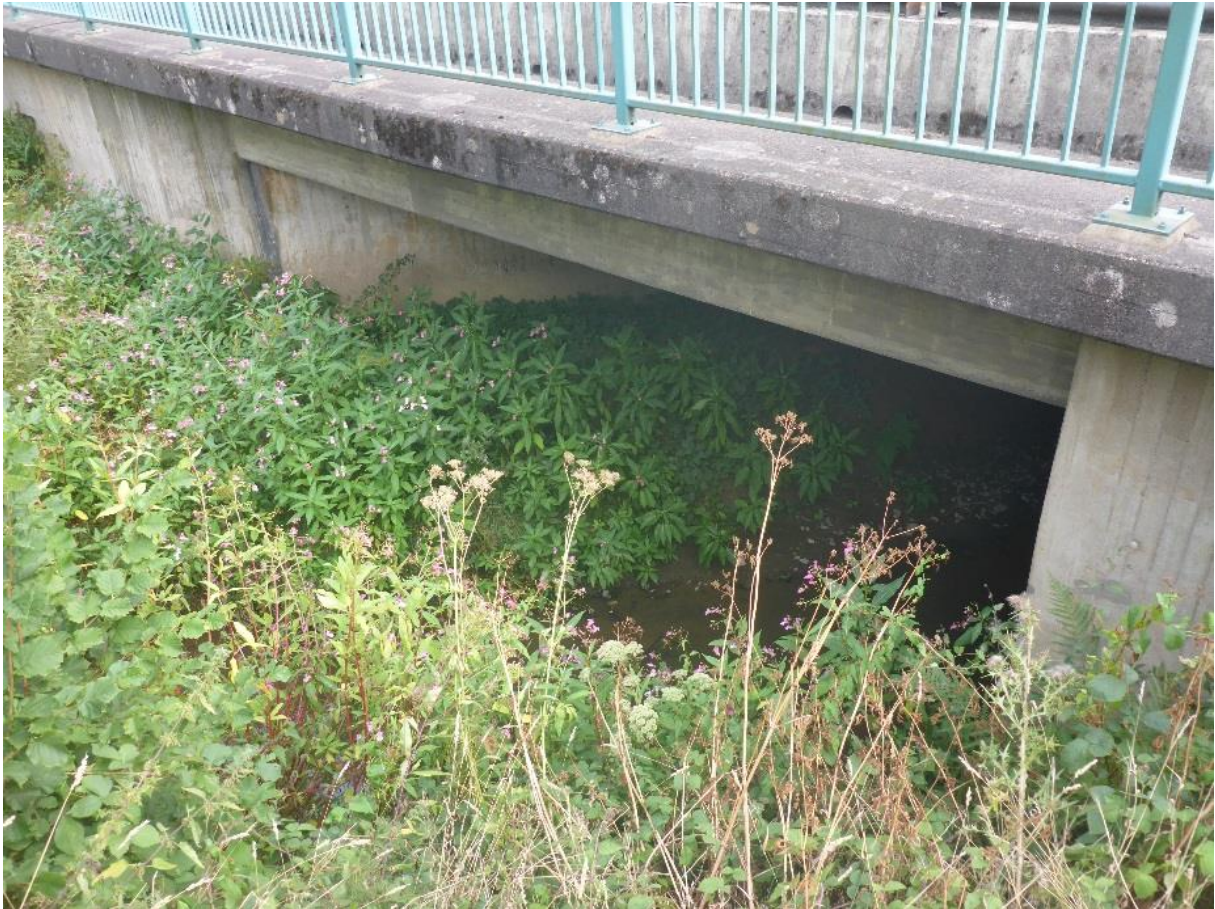
Brücke von oberstrom
